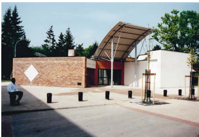
▲ Maison de quartier à Cléon Sud
